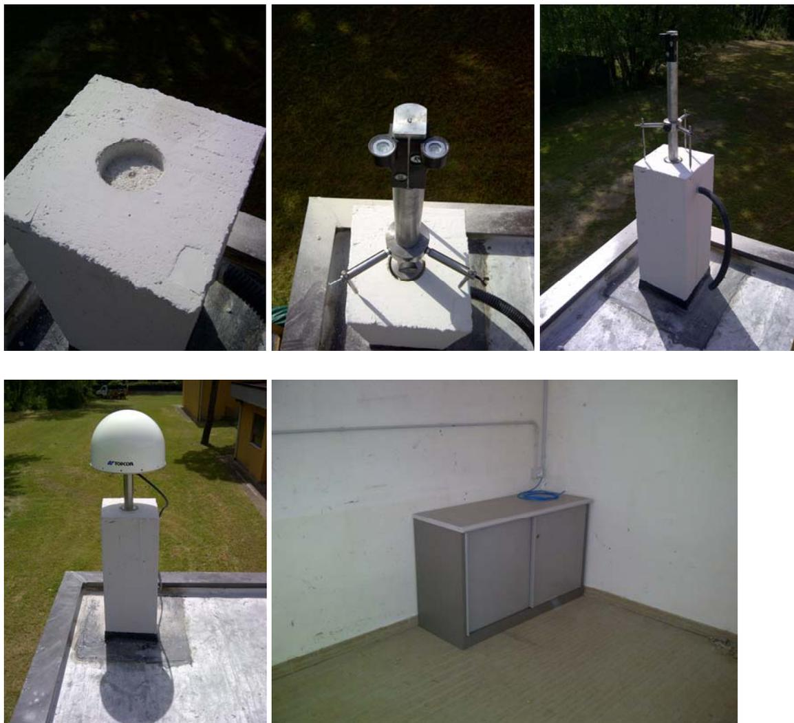
*Figura 4. Sequenza fotografica che mostra le diverse fasi di installazione del supporto antenna e della stessa.*
